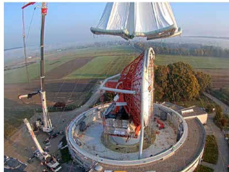
Die Erneuerung der Radomhülle
