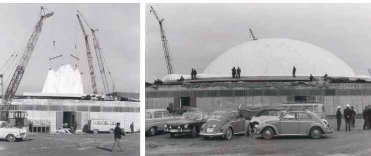
Errichtung der Traglufthülle im Oktober 1963.
